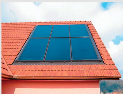
Kolektory słoneczne Vitosol 200-F na budynku jednorodzinnym.
